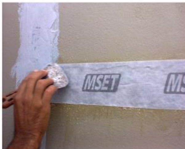
Figura 6 - Etapas do sistema de recuperação de fissuras (IMPERCIA, 2014).
