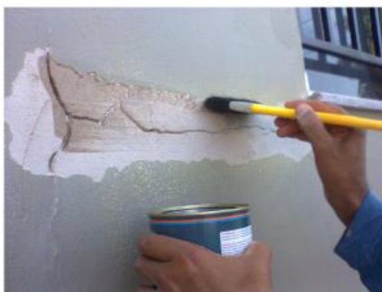
Figura 2 - Aplicação do primer (IMPERCIA, 2014).
