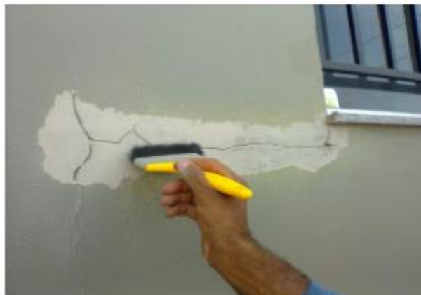
Figura 1 - Limpeza e abertura da fissura (IMPERCIA, 2014).
