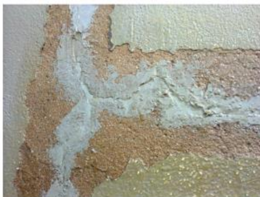
Figura 4 – Aplicação da segunda demão de primer (IMPERCIA, 2014).
