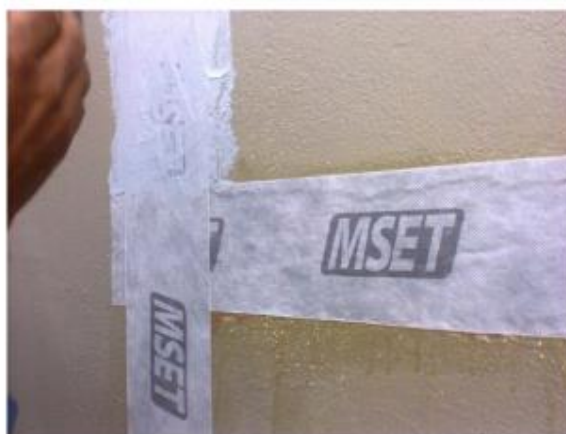
Figura 5 - Aplicação da fita autoadesiva (IMPERCIA, 2014).
