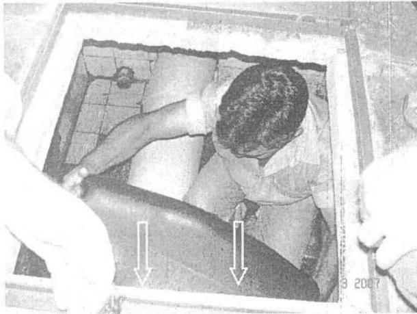
Foto 7 – Caixa coletora da água do tubo “extravador” dos poços Mayrink 1, 2 e 3: momento de medição da vazão.
