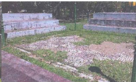
Área desativada, com estruturas danificadas
