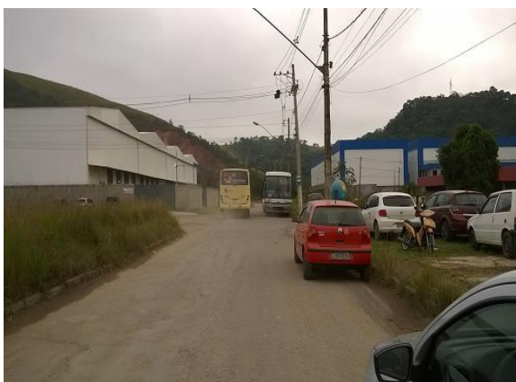
Foto 11: Falta de pavimentação asfáltica e estacionamento.
