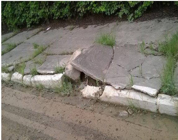
Foto 7: Condição degradada dos passeios.
