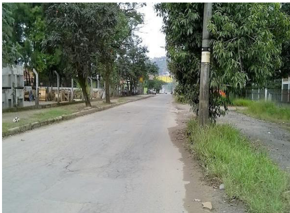
Foto 9: Falta de tratamento paisagístico.
