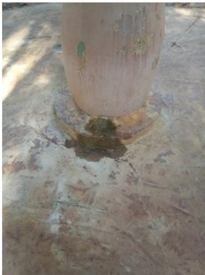
Foto 7. Marca de vazamento intermitente na base do bulbo.
