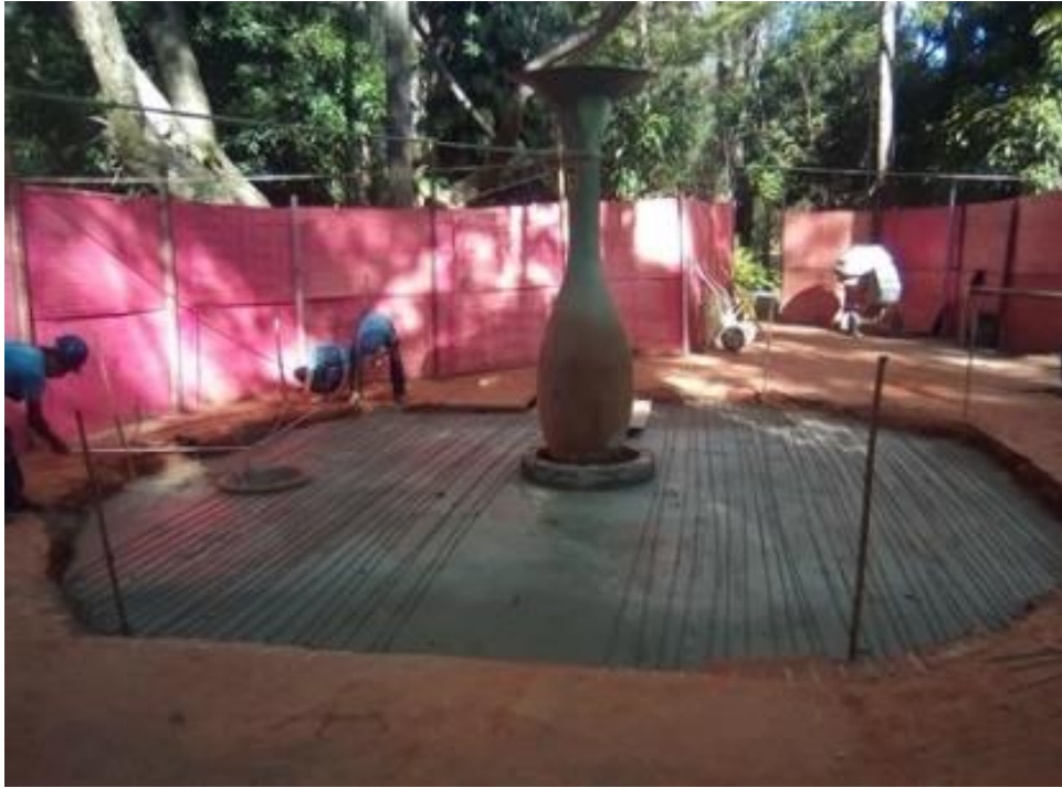
Foto 2. Laje de concreto utilizada para compor o topo do piso no entorno do gêiser.
