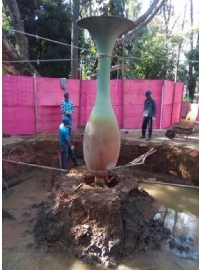
Foto 6. Detalhe da escavação no entorno do poço e do cogumelo. Na base do bulbo veem-se as sapatas de apoio do cogumelo no solo.
