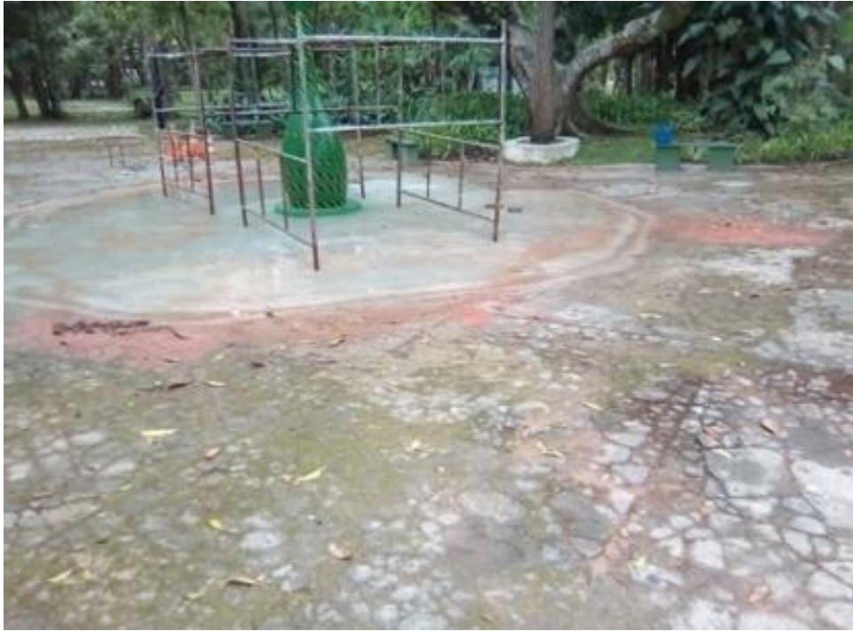
Foto 4. Laje depois de concluída.
