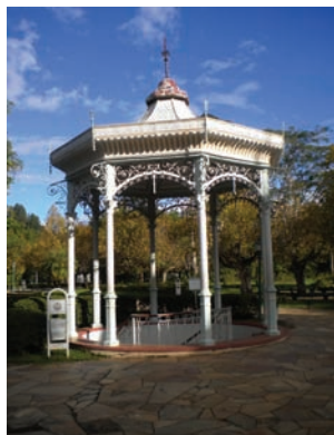
Fig. 10 – Pavilhão da fonte Duque de Saxe.
