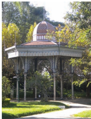
Fig. 13 – Pavilhão da fonte Dona Leopoldina.
